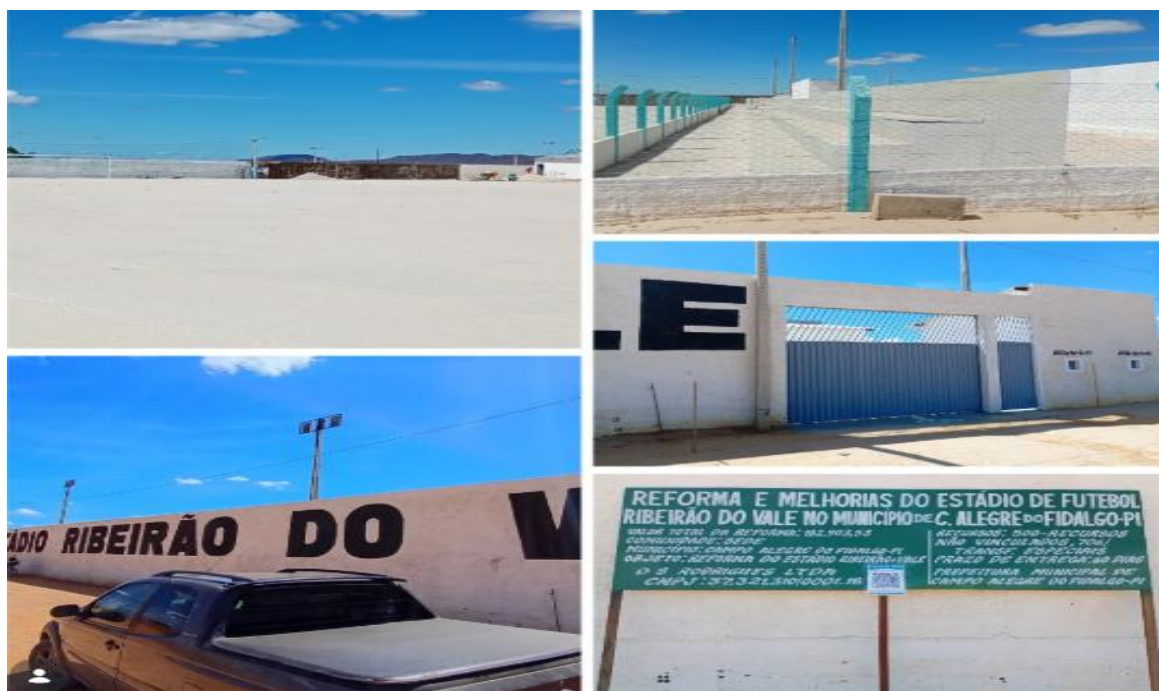
Figura 6 - Obras de melhorias no Estádio Ribeirão do Vale
